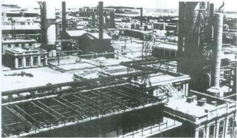
Şökil 25. Bakı şəhərində neftayırma zavodunun ümumi görünüşü (1937)
