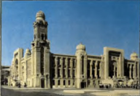
Bakı. Dəmiryol vağzalının binası, 1926-cı il
